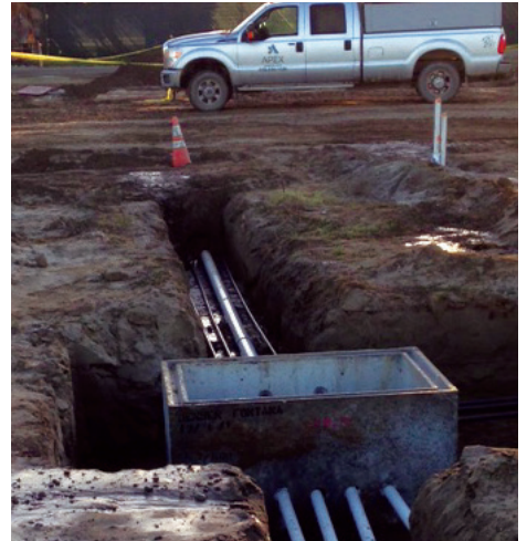
Instalación de Tubería de Remediación
