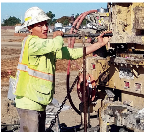
Instalación de Pozos de Remediación
